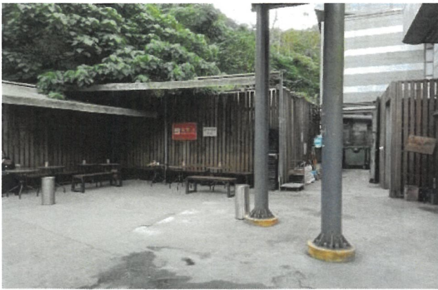
原設置點:火化場左側
